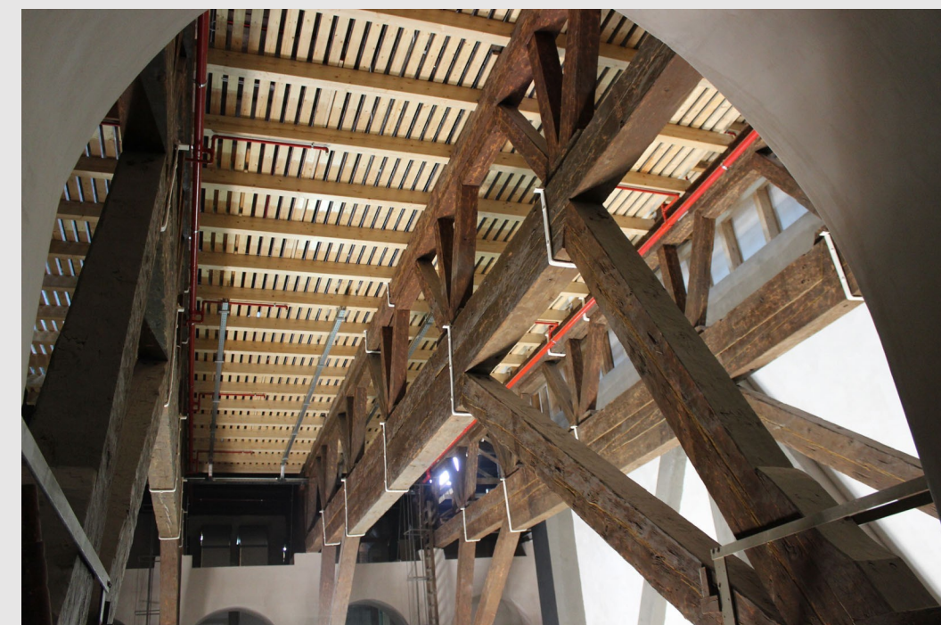
ESECUZIONE DEI LAVORI: nuovo piano di graticcia
