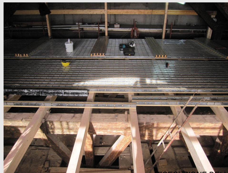
ESECUZIONE DEI LAVORI: nuovo piano di graticcia
