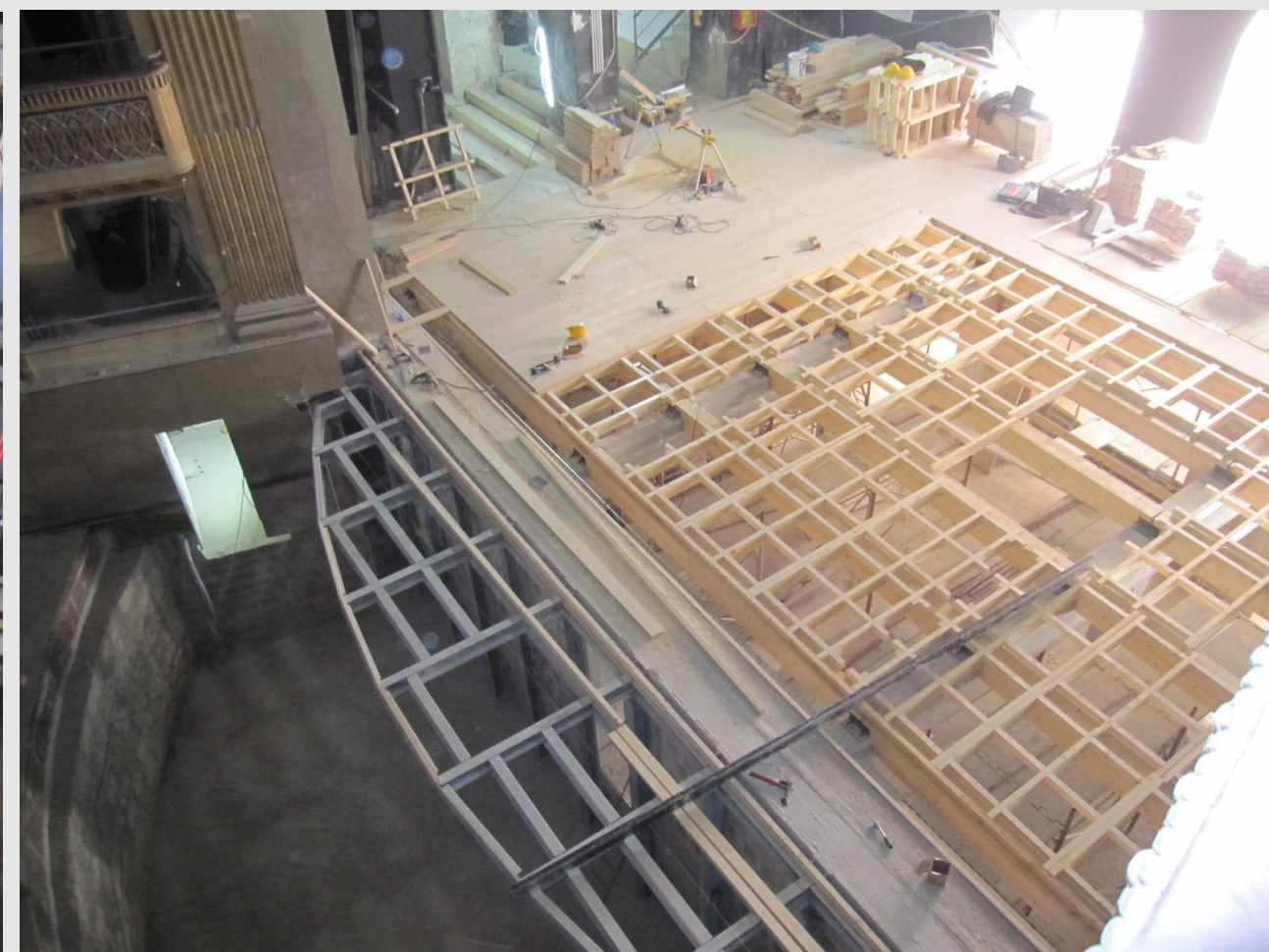
ESECUZIONE DEI LAVORI: nuovo piano di palcoscenico e graticcia
