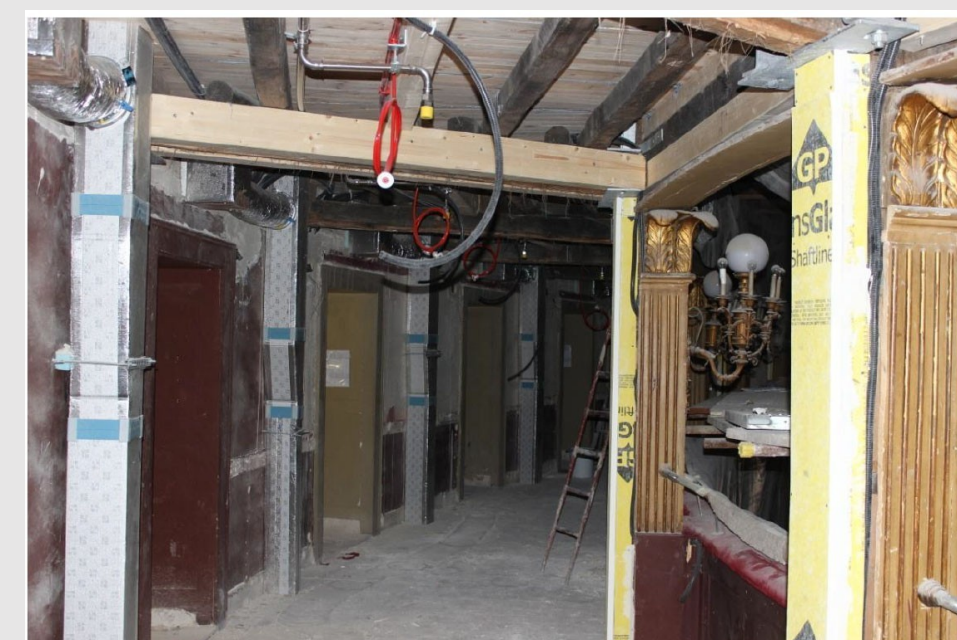
GALLERIA IV ORDINE : NUOVI CABLAGGI E CANALIZZAZIONI ARIA
